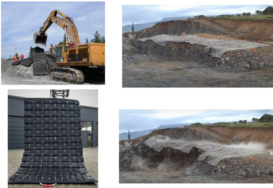
Slika 6.9. Miniranje primenom teških zaštitnih prekrivki
